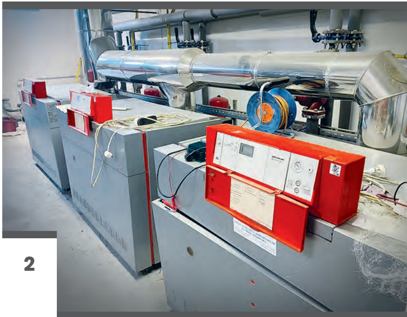
2. kép A fűtésről három gázkazán gondoskodott, komoly rezsiköltséget eredményezve
