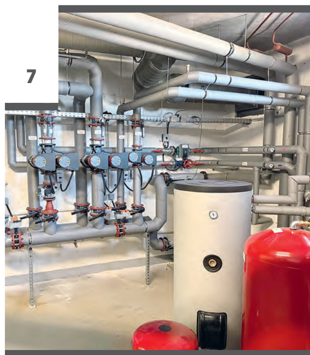
7. kép A használati meleg víz tartályját a korszerűsítés során egy 2 csőkégyóval szerelt, 300 literesre cserélték
