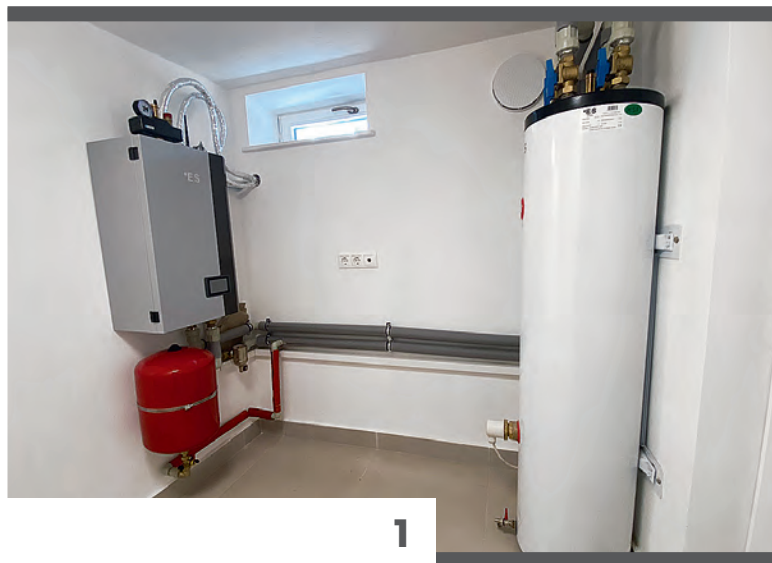
1. kép Szplit rendszerű hőszivattyú minimális helyszükséglete az épületen belül
