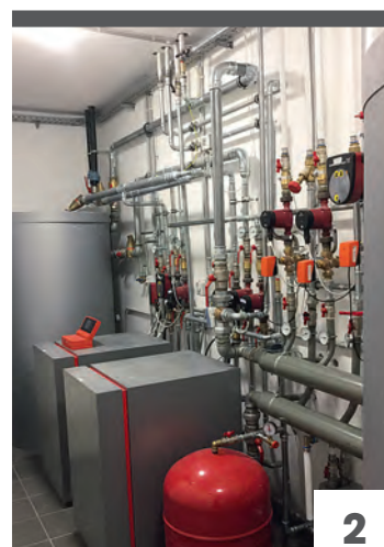
2. kép Talajszondás hőszivattyú a beltérben egy komoly hőközponttal
