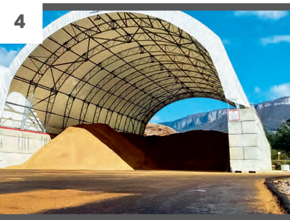
4. kép Faapríték tárolására épített depó
